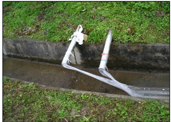
湧水を塩ビ管やホース等で集めて補修箇所に流れ込まないようにする。
