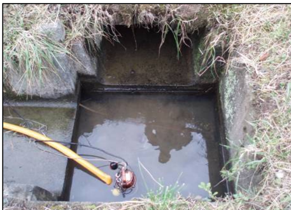
柵に溜まっている水はポンプを使って汲み出し、補修箇所の水路に流れ込まないようにする。
