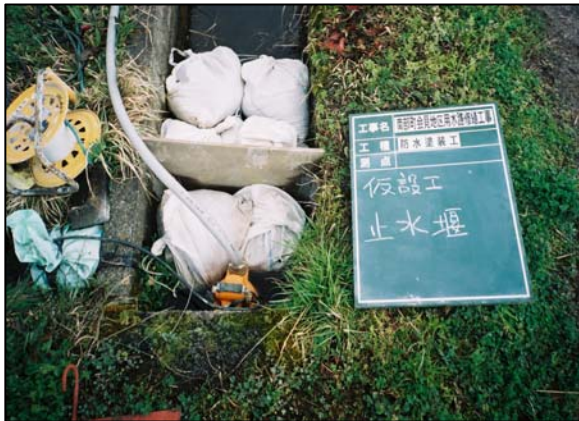
土のうで水をせき止め、ポンプ、塩ビ管等で補修箇所を迂回させる。
