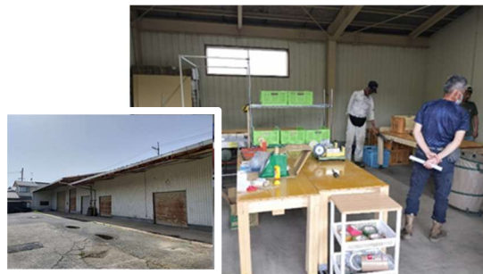
写真2: JA 遊休施設を改修し出荷調製作業場を整備
