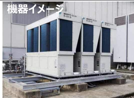
空冷ヒートポンプチラー（電気式）
