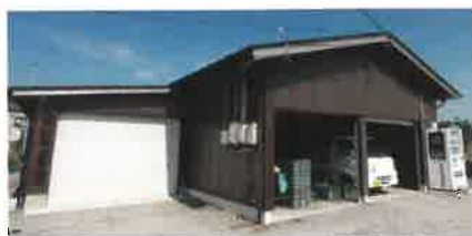
【新築した作業場】
