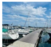
▲エコウッドを使用した栈橋(境港公共マリナ)
