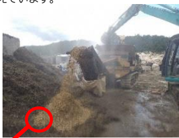
▲木くずは破碎・チップ化し、製紙原料等に再生使用
