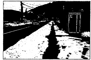
復旧作業の完了
