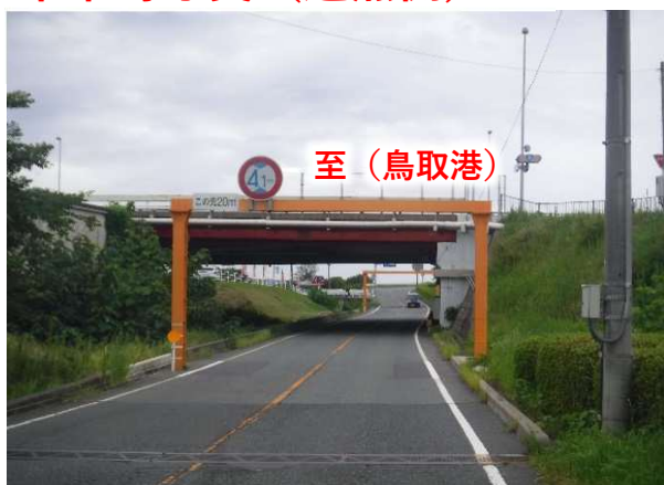
平常時写真 (起点側)
