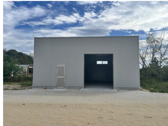
外観 (シャッター オープン時)
