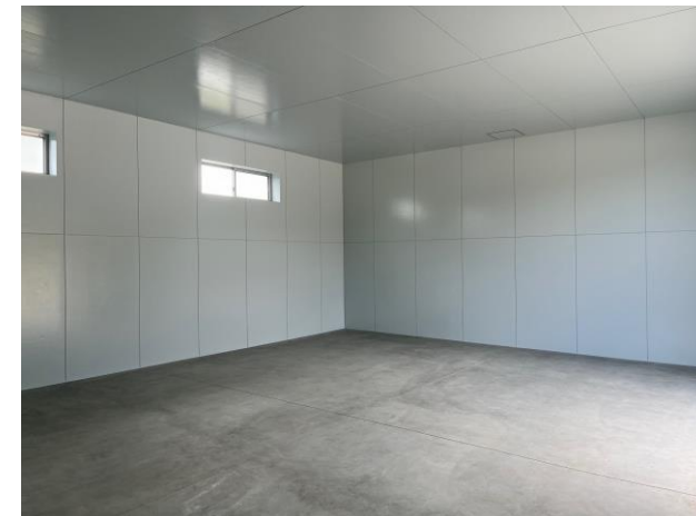
車庫内 (右奥側)
