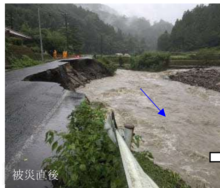
令和2年9月豪雨 国道482号(佐治町尾際) 護岸崩壊、道路流失
