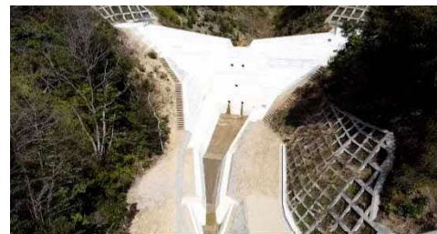
みどり下谷川砂防えん堤
