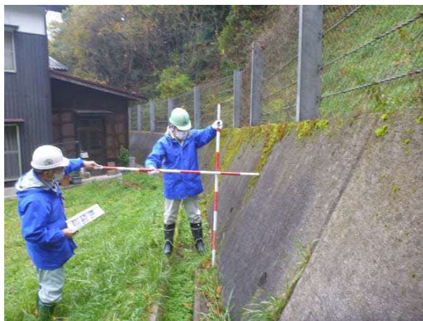
急傾斜地点検の様子
