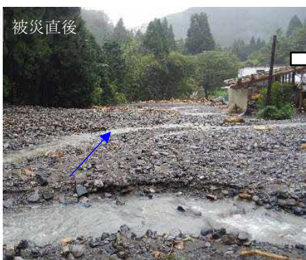
令和2年9月豪雨 北谷川(佐治町尾際) 土砂流出による河道埋塞
