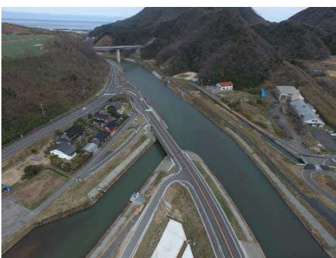
改修が進む塩見川
