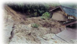
H23年9月豪雨 倉吉市関金町で発生したがけ崩れ
