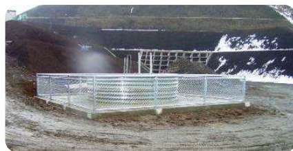
地すべり対策（集水井）
