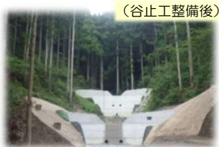
（谷止工整備後）
