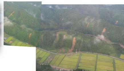
H19.8 琴浦町中村地区で集中的に発生した山腹崩壊
