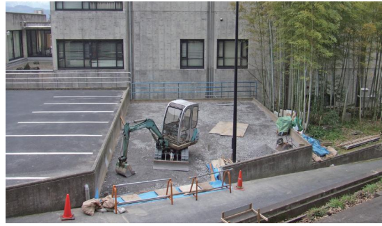
平成21年3月 駐車場整備工事
