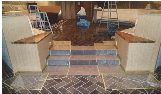
平成27年2月 喫茶スペース改修工事
