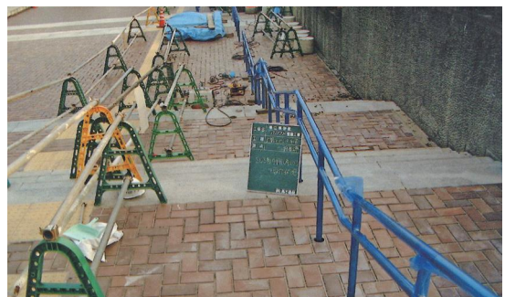
平成14年2月 バリアフリー工事 階段手すり設置
