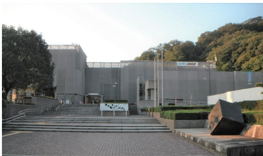
平成28年9月 外壁等改修工事
