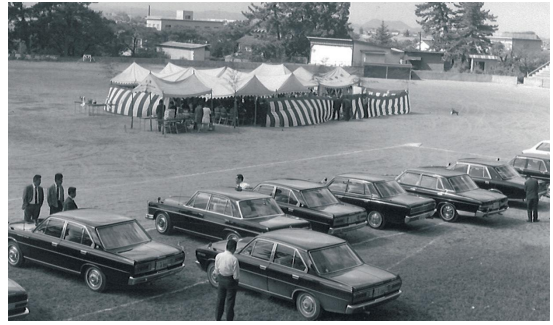
昭和45年 建設工事着工
