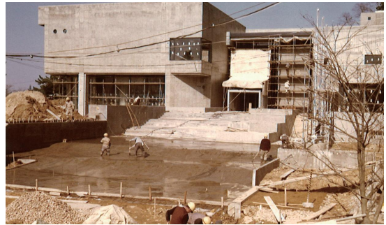
昭和45年～ 建設工事の様子
