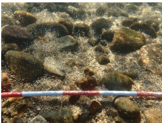
図13 造成後の河床の様子 ※写真中のポールは5cmピッチで色分け
