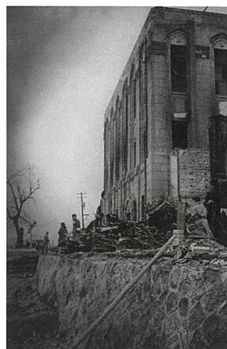
⑦ 焼損した国警ビル(昭和27年)
