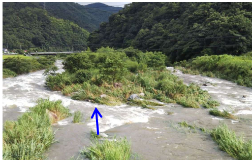
<天神川（三朝町曹源寺）>
