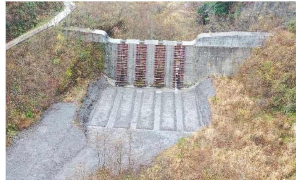
掘削+置き土の工事後(R3.12)
