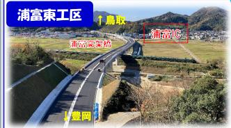
浦富高架橋では、ついに舗装工事が完了しました!現在 は、ガードレールなどの安全施設工事が順調に進み、区画 線工事の準備も始まっています。
