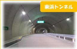
東浜シネル内では、照明や非常用設備な どの電気関係工事のほか、中央分離帯の ガードレール設置も完了しました!
