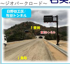
日野谷工区内の盛土工事や水路設 置も完了し、今後は、什上げの路盤や 舗装工事が始まります。
