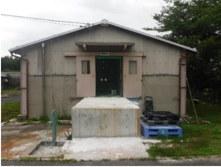
1 出入口設置場所外観
