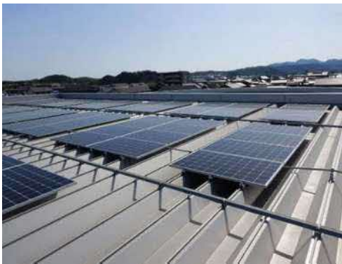
▲会社屋上の太陽光パネル
