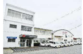
▲本社外観(鳥取市商栄町)
