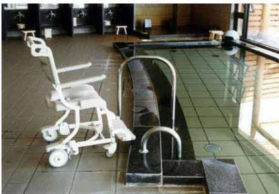
・手すり、階段、天井走行式の介助用リフトを設置した貸し切り浴室
