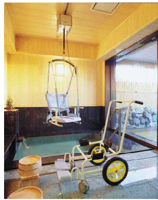
・手すり、階段、天井走行式の介助用リフトを設置した貸し切り浴室
