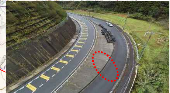
< 日野町管内対応用土のう仮置場 >
