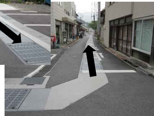
山からの雨水を安全に河川に排水
