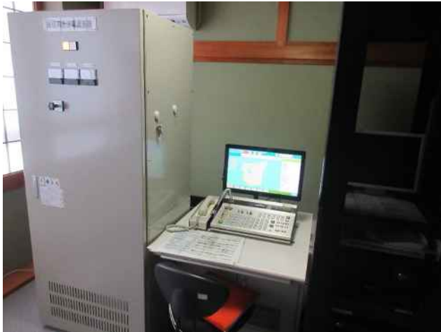
■ 防災無線設備の移設（庁舎1階から2階へ）
