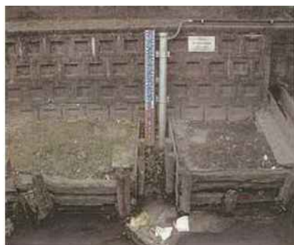
水位計設置状況
