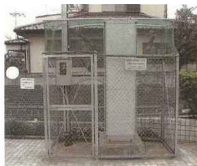
観測装置設置状況
