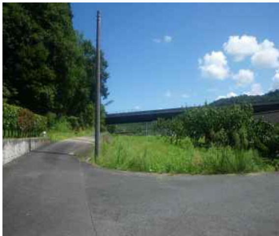
米里12号線(施工前)
