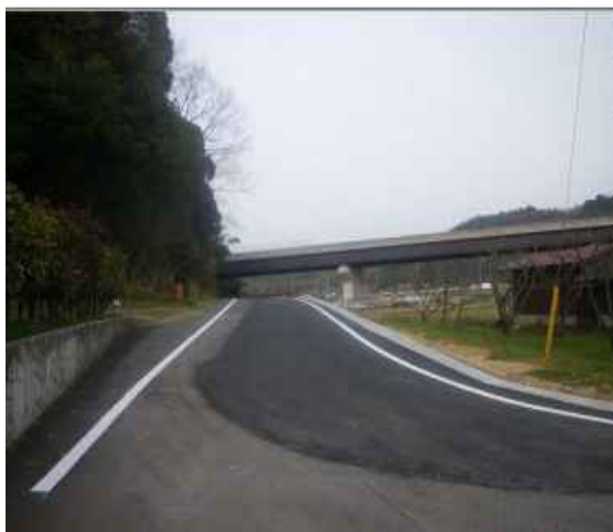
米里12号線(拡幅後)
