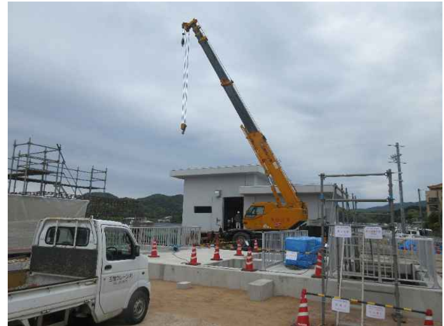
■ 排水機場整備
