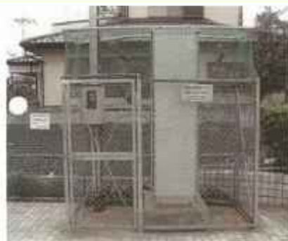
観測装置設置状況
