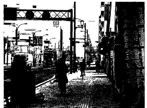
電線類の地中化を行った国道180号線(米子市)
