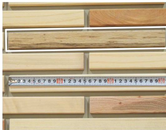
写真2 施工された木製タイル(拡大)
