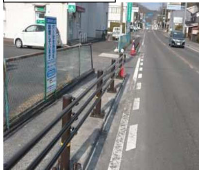
防護柵整備箇所
