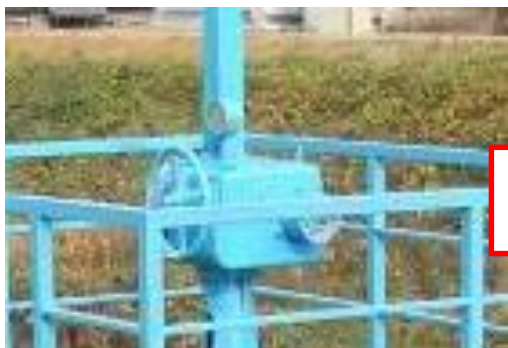
手動(ハンドル)式の樋門
