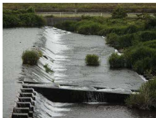
写真5-1 下流側に突出した形状の魚道
