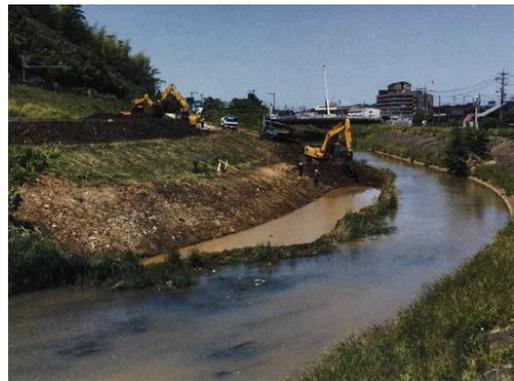
写真 6-7 濁水発生防止の工事例
