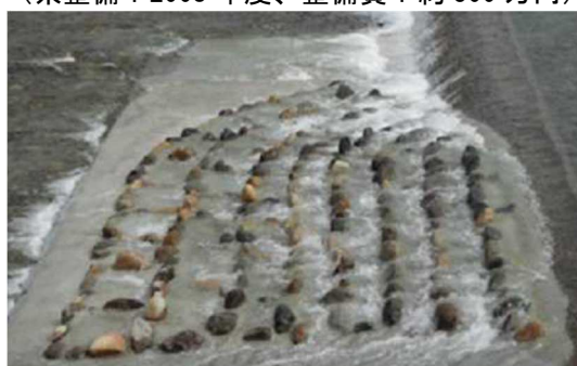
図 16-4 千代川大井手用水堰 左岸側 (県整備：2018 年度、整備費：約 400 万円)
