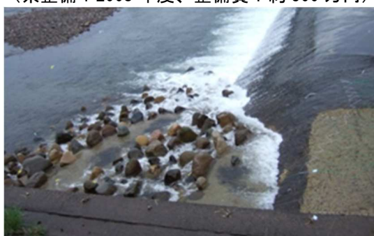
図 16-3 日野川車尾堰 左岸側 (国整備：2007 年度)
