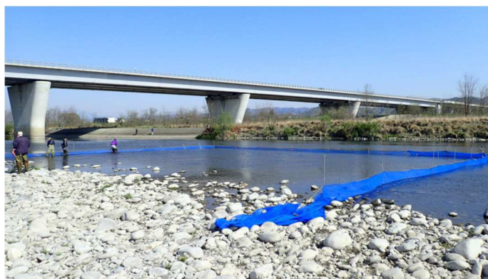
図4 設置事例（栃木県水産試験場提供）
