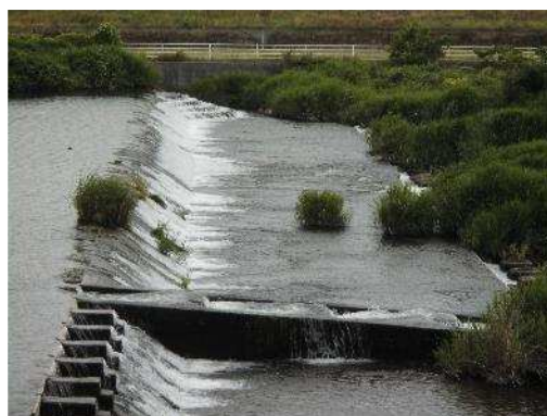
図15 下流側に突出した形状の魚道 (天神川 郡山大口堰)
