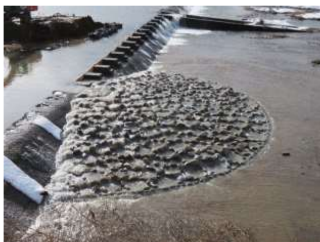
(参考) 完成後の魚道 令和7年2月10日
