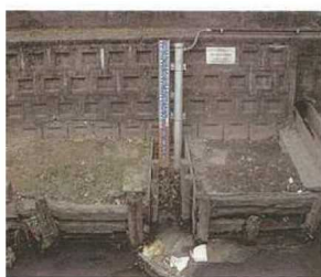
水位計設置状況
