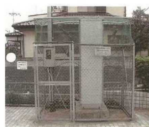
観測装置設置状況
