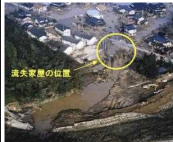
←堤防決壊に伴う氾濫流で木造家屋が倒壊した状況
