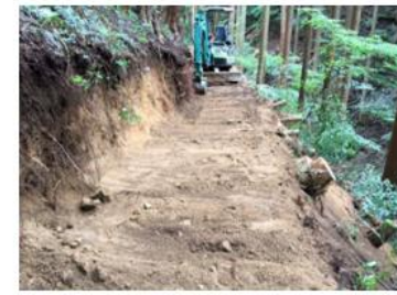
管理歩道設置
