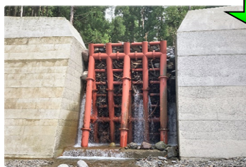
砂防えん堤完成後の令和5年8月の台風第7号が襲来した際土砂及び流木を捕捉し効果を発揮
