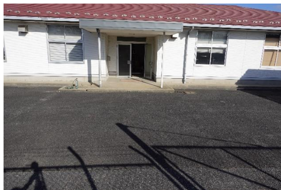
【f 旧空港建設事務所入り口】
