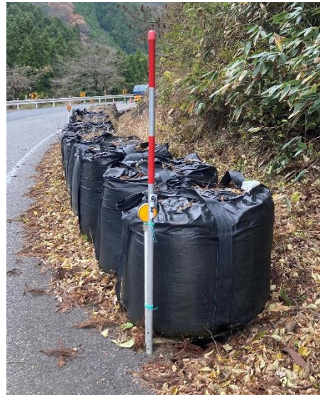
【西伯根雨線 落石対策 応急措置 土のう袋】
