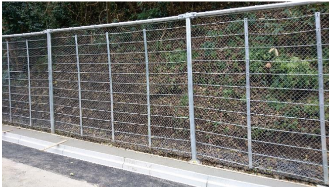
【西伯根雨線 落石防護柵】
