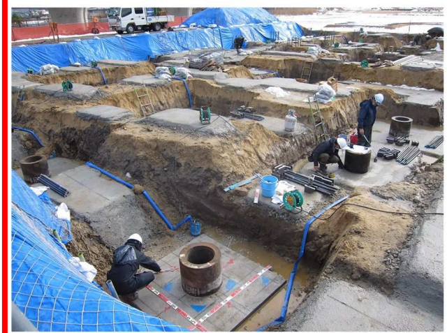
写真②展示ガイダンス施設の建築基礎工事（西から）
