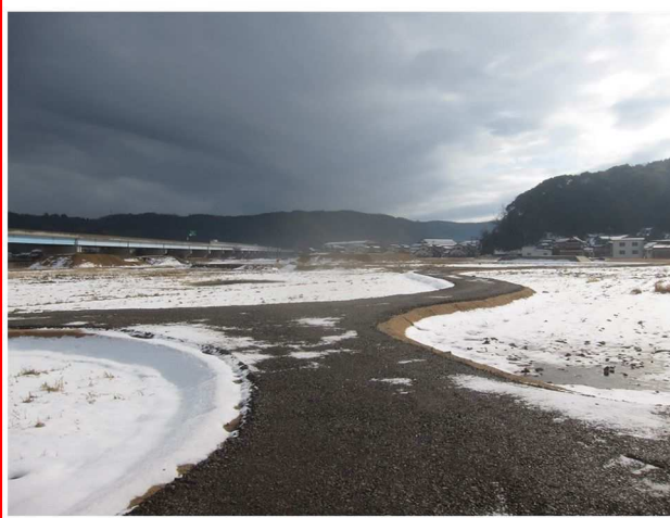
写真③園路設置状況（整備中は工事用道路として使用）
