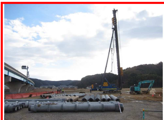
写真①展示ガイダンス施設の建築工事（南東から）
