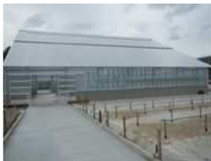
コンテナ苗生産施設（R3.11月、日南町阿毘縁）
