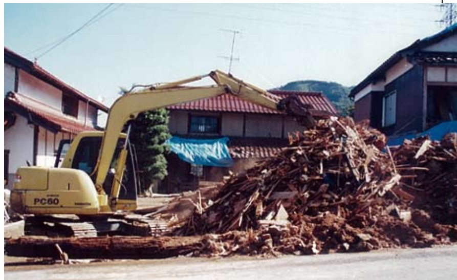
取り壊される被災住宅
