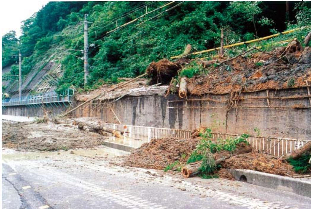
余震で新たに流出した土砂で覆われた国道181号とJR伯備線。線路復旧作業中だった作業員らは、間一髪難を逃れた。（日野町）
