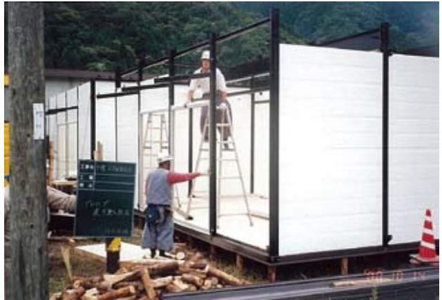
建設中の仮設住宅
