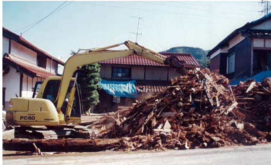
取り壊される被災住宅
