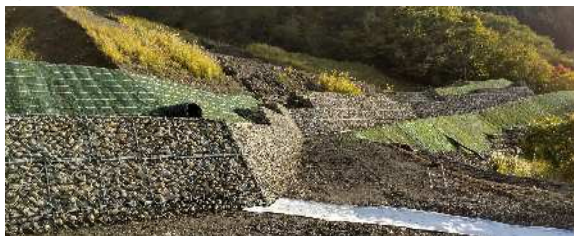
【土留工(11月完成)】
