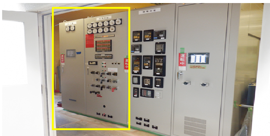
制御装置（出力盤、発電機制御盤）
