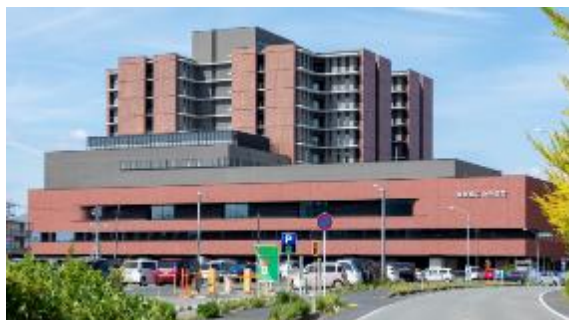
新病院の全景
