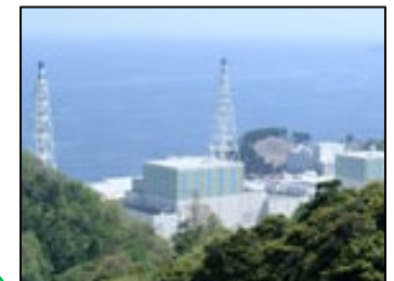
島根原子力発電所
