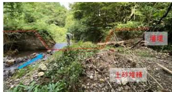
写真2 土砂を捕捉し満砂となった砂防堰堤の例（下谷川（三朝町））
