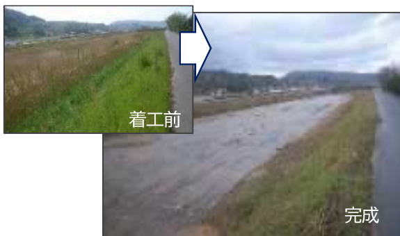
<樹木伐採、河床掘削の進捗状況>
