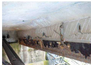
▲ 主桁の損傷状況
