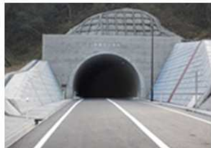
トンネル（日野溝口線 矢倉トンネ
