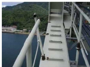
▲ 監査路の腐食・破断状況
