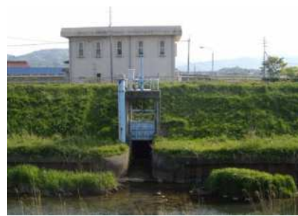
排水機場（西大路排水機場）
