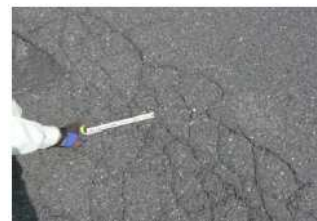
▲ 舗装のひび割れ
