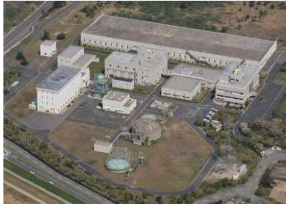
終末処理場（天神浄化センター）
