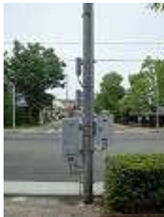
交通信号機（制御機）
