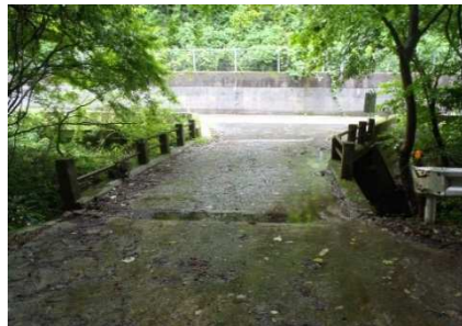
橋りょう（内井谷線 1号基）
