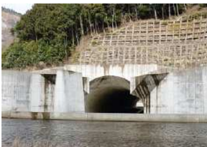
河川トンネル（市瀬トンネル）
