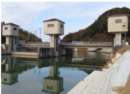
水門（塩見川潮止堰）
