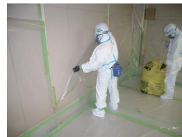
養生シートの撤去
