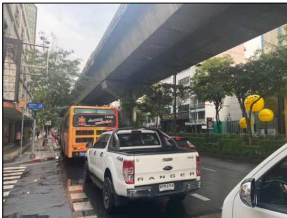
電線の地中化が進む大通
