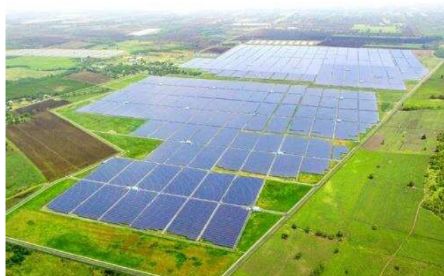
タイ最大級の太陽光発電所(出力84MW)シャープが受注建設・ロブリー県 出典：タイ発電事業会社 Natural Energy Developmnet Co.,Ltd.
