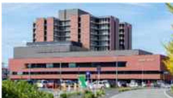
新病院の全景
